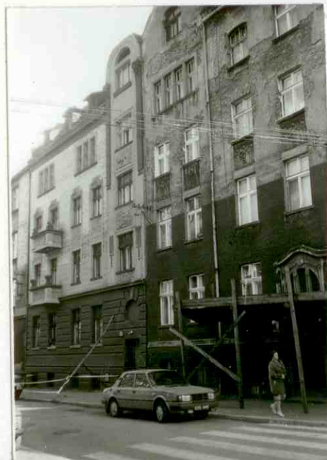
FRAGMENT ELEWACJI FRONTOWEJ
