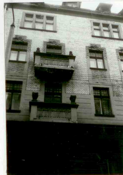
FRAGMENT ELEWACJI FRONTOWEJ
