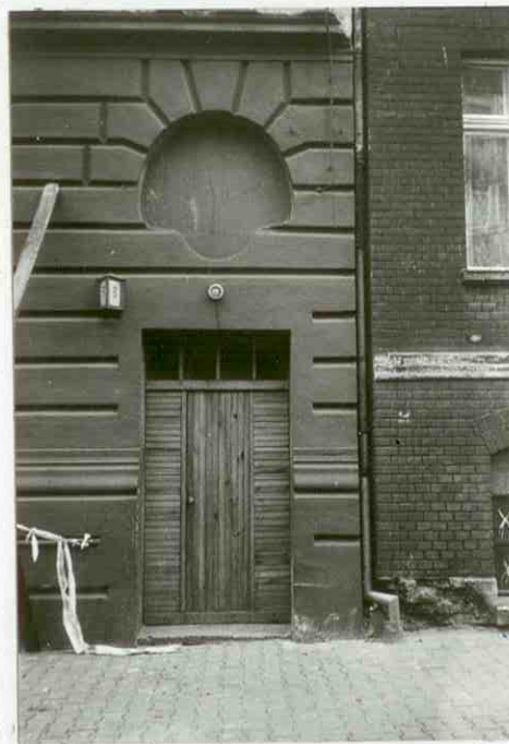
WEJŚCIE DO BUDYNKU
