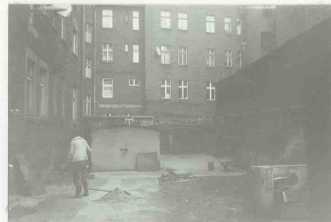
OTOCZENIE BUDYNKU - WIDOK OD PODWÓRZA
