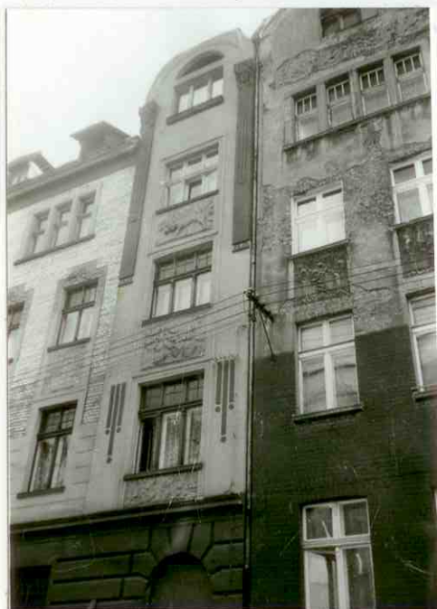
FRAGMENT ELEWACJI FRONTOWEJ
