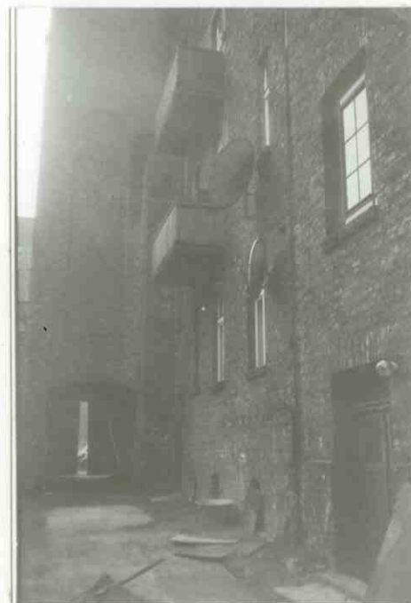
OTOCZENIE BUDYNKU - WIDOK OD PODWÓRZA
