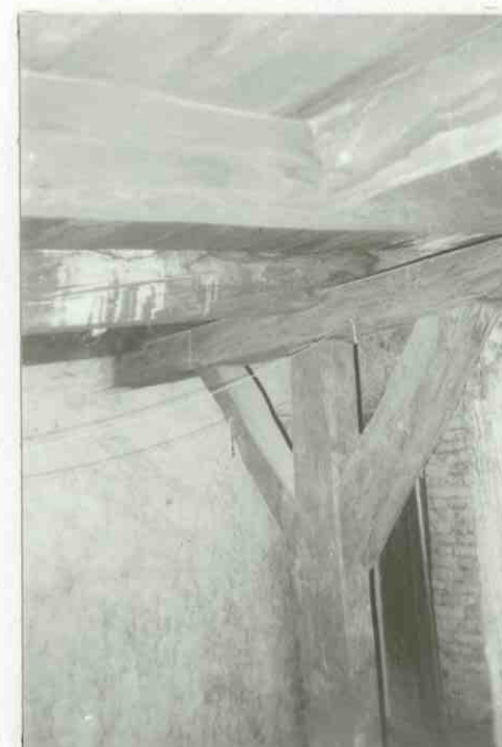
FRAGMENT WIEŻBY DACHOWEJ
