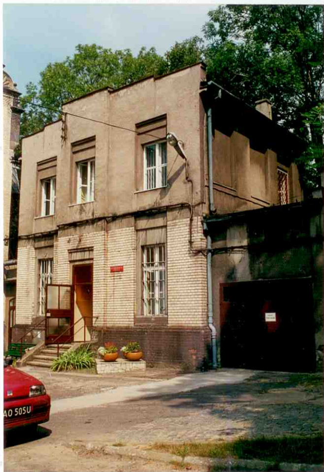
1. Elewacja południowo-zachodnia (frontowa) wraz z widokiem na elewację południowo-wschodnią.
