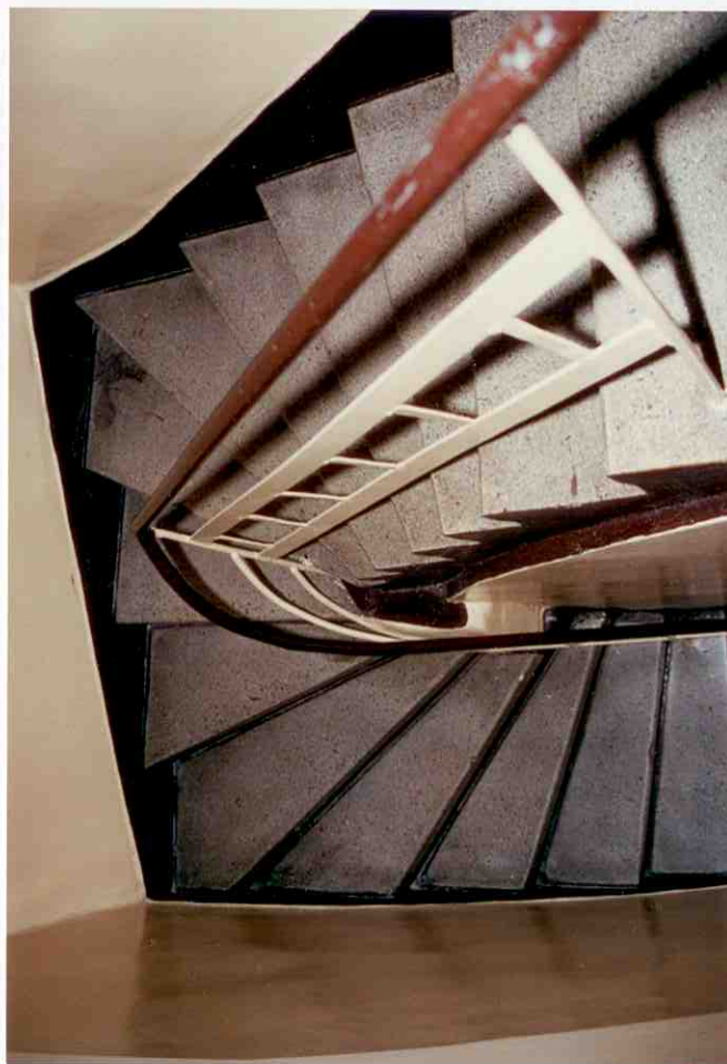
5. Fragment klatki schodowej.
