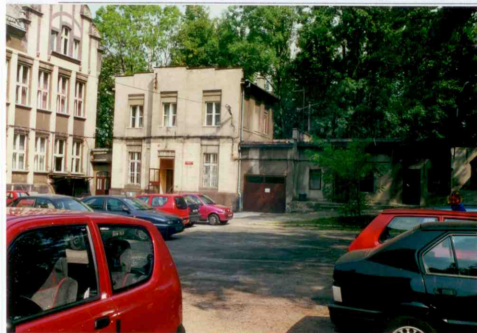
Elewacja południowo-zachodnia (frontowa).
