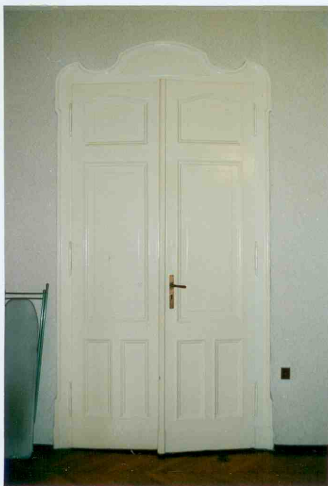
DRZWI W LOKALU MIESZKALNYM - II PIĘTRO
