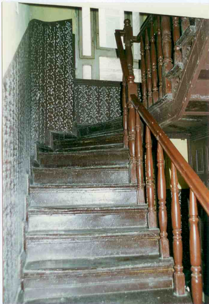
BOCZNA KLATKA SCHODOWA OFICyna ZACHODNIA
