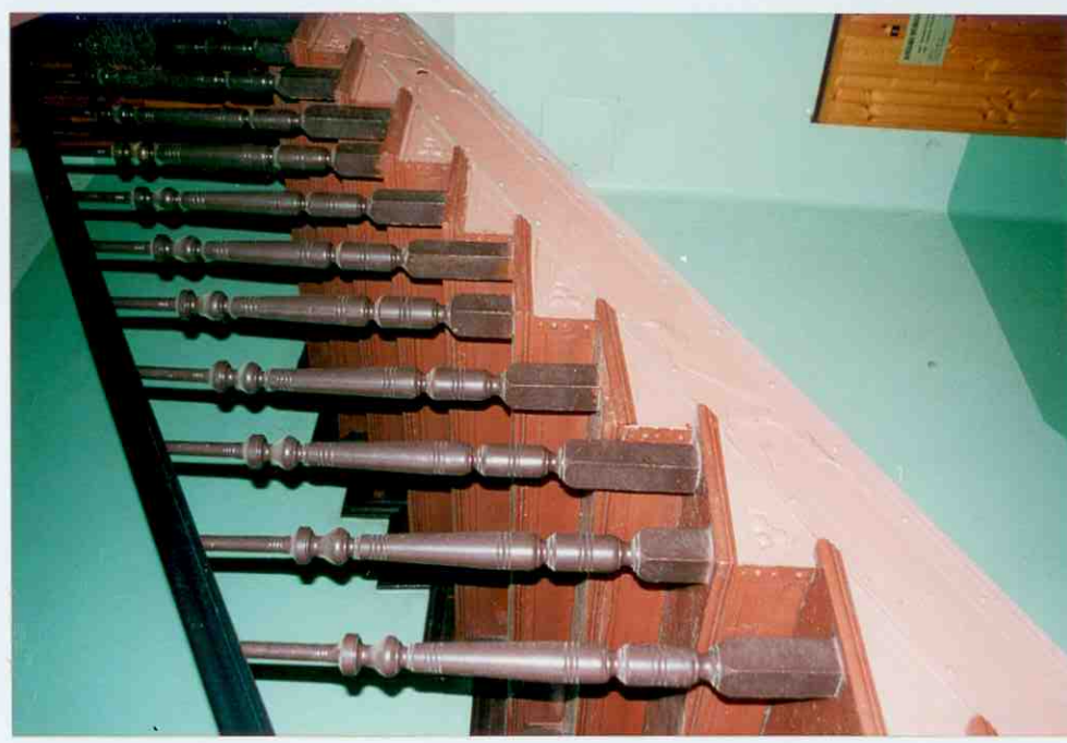
BALUSTRADA GLÓWNEJ KLATKI SCHODOWEJ
