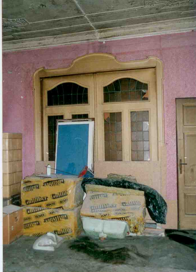
DRZWI W LOKALU MIESZKALNYM - II PIĘTRO
