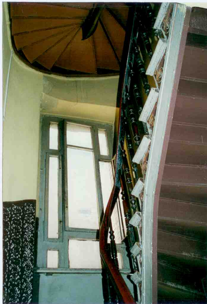
BOCZNA KLATKA SCHODOWA OFICyna ZACHODNIA
