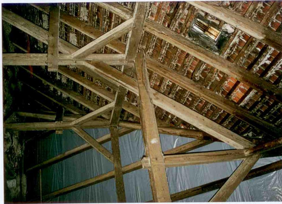
50 - Fragment więźby dachowej - korpus główny budynku
