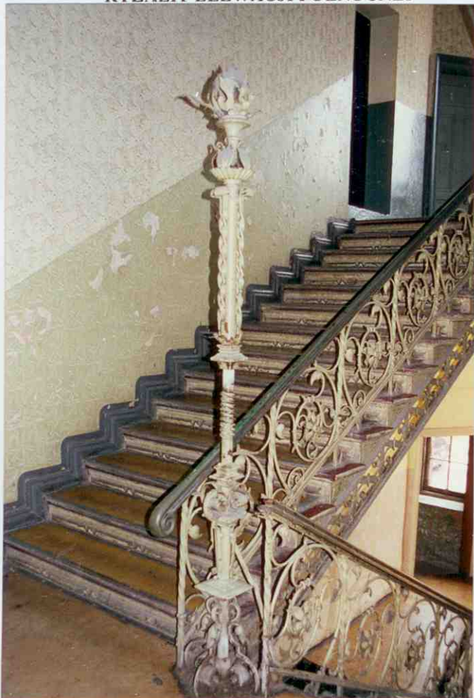
GLÓWNA KLATKA SCHODOWA
