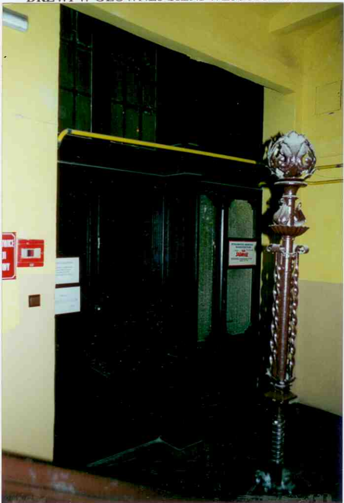
DRZWI WEJŚCIOWE DO LOKALI NA I PIĘTRZE
