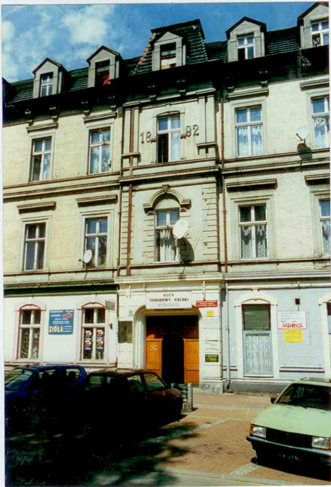
FRAGMENT ELEWACJI FRONTOWEJ
