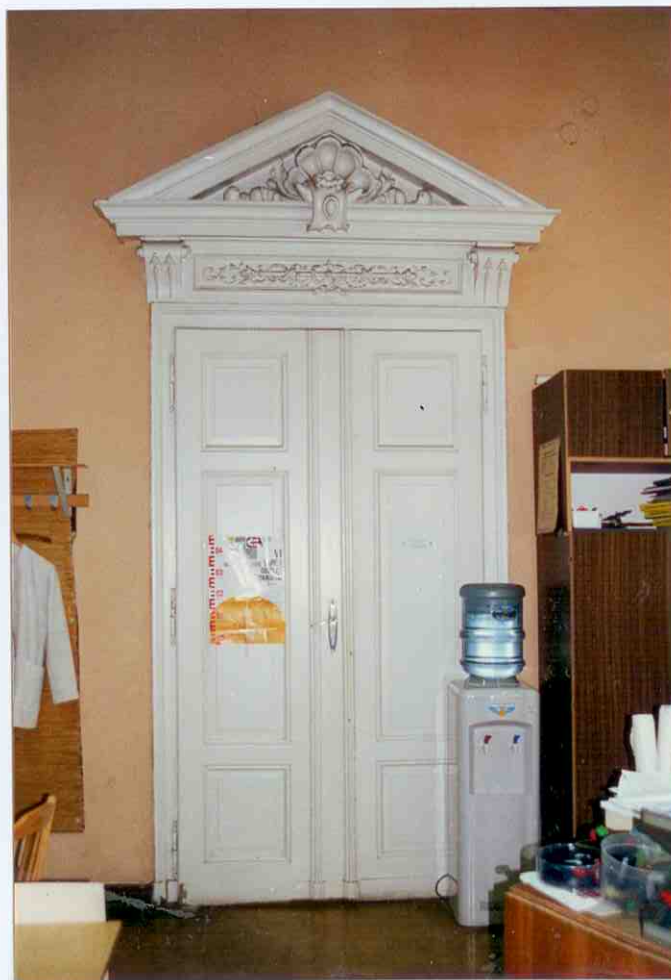
DRZWI W LOKALU NA I PIĘTRZE
