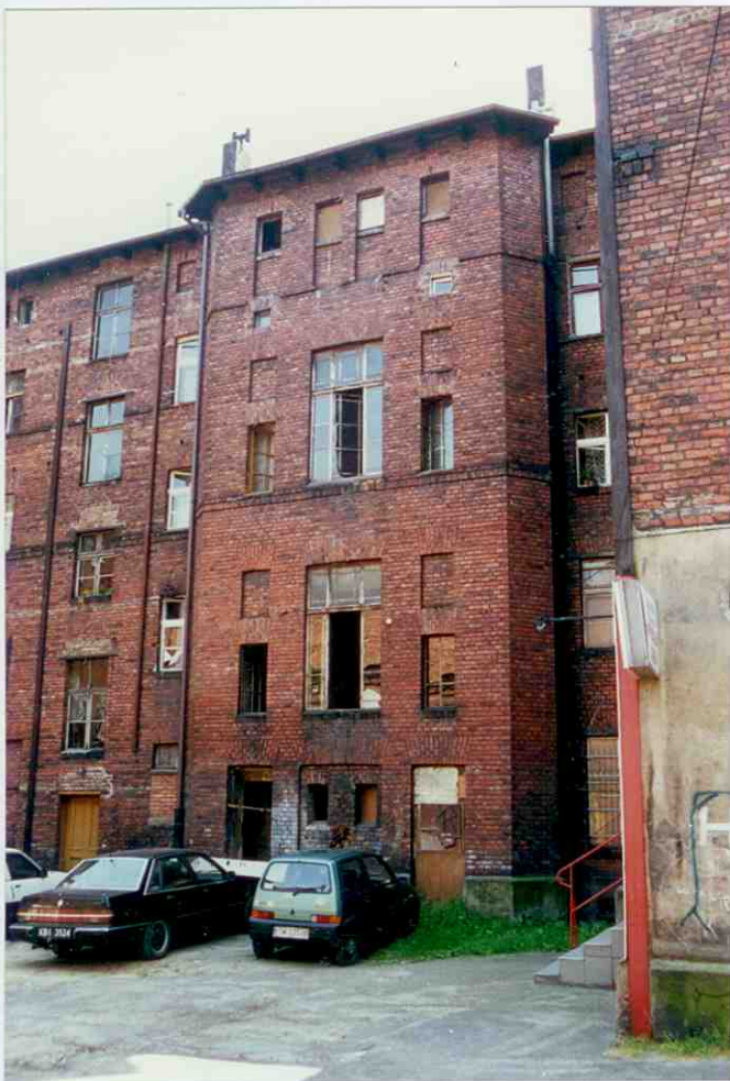
RYZALIT ELEWACJI PÓLNOCNEJ
