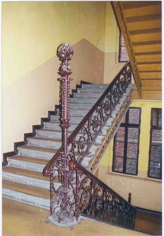
GLÓWNA KLATKA SCHODOWA (ZACH.)
