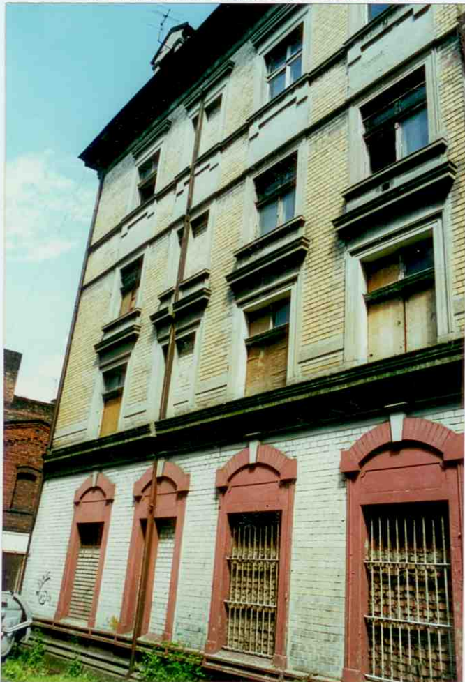
FRAGMENT ELEWACJI ZACHODNIEJ
