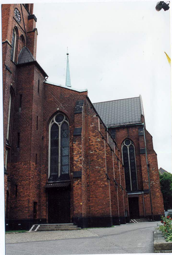
7 - FRAGMENT ELEWACJI ZACHODNIEJ I ELEWACJA POŁUDNIOWA
