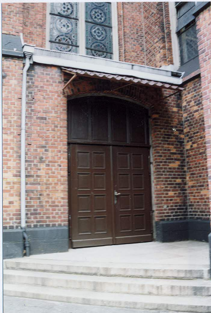
13 - BOCZNE DRZWI ZEWNĘTRZNE W FASADZIE
