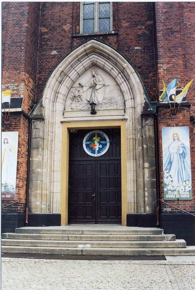
10 - GŁÓWNE WEJŚCIE DO KOŚCIOŁA
