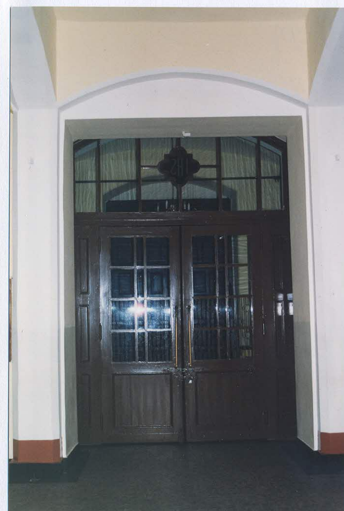
21 - DRZWI WEWNĘTRZNE Z PRZEDSIONKA GŁÓWNEGO DO NAWY
