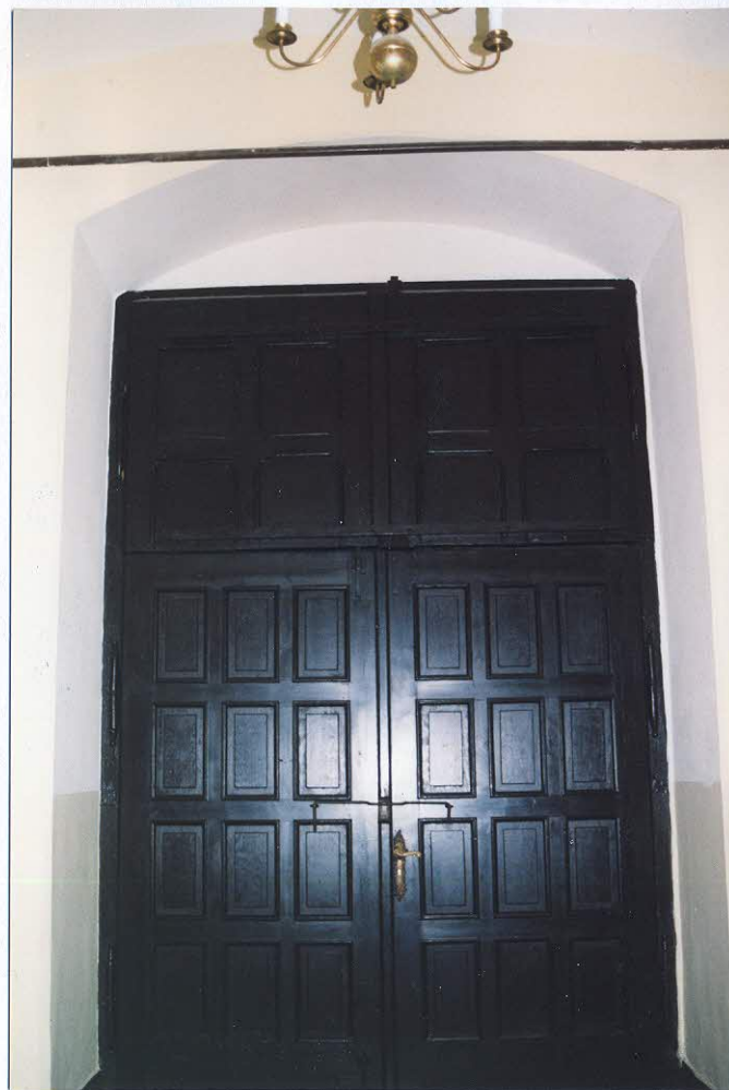
11 - GŁÓWNE DRZWI ZEWNĘTRZNE (WIDOK OD PRZEDSIONKA)
