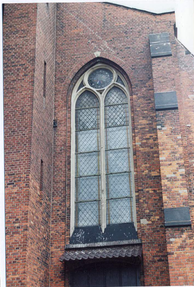
8 - OKNO W NAWIE
