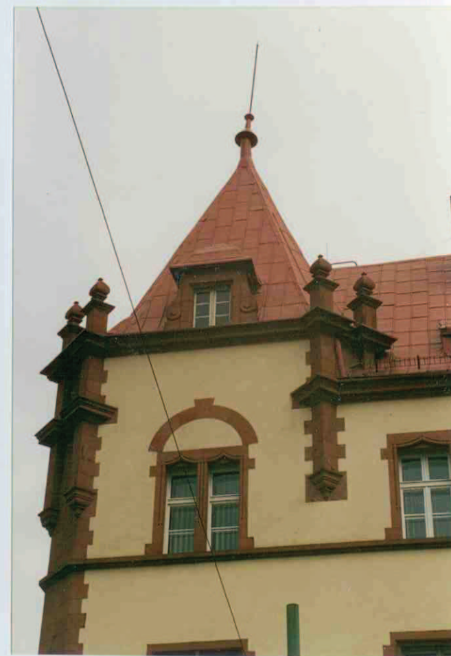
15. Fragment elewacji zachodniej.
