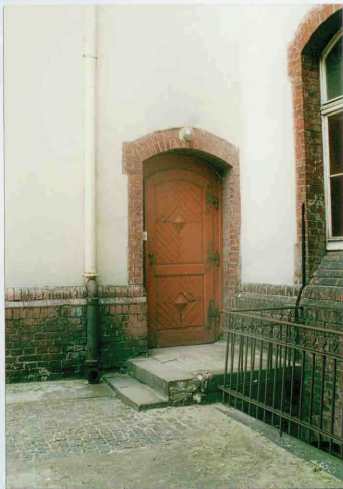
13. Drzwi. Fragment elewacji południowej-tylnej.
