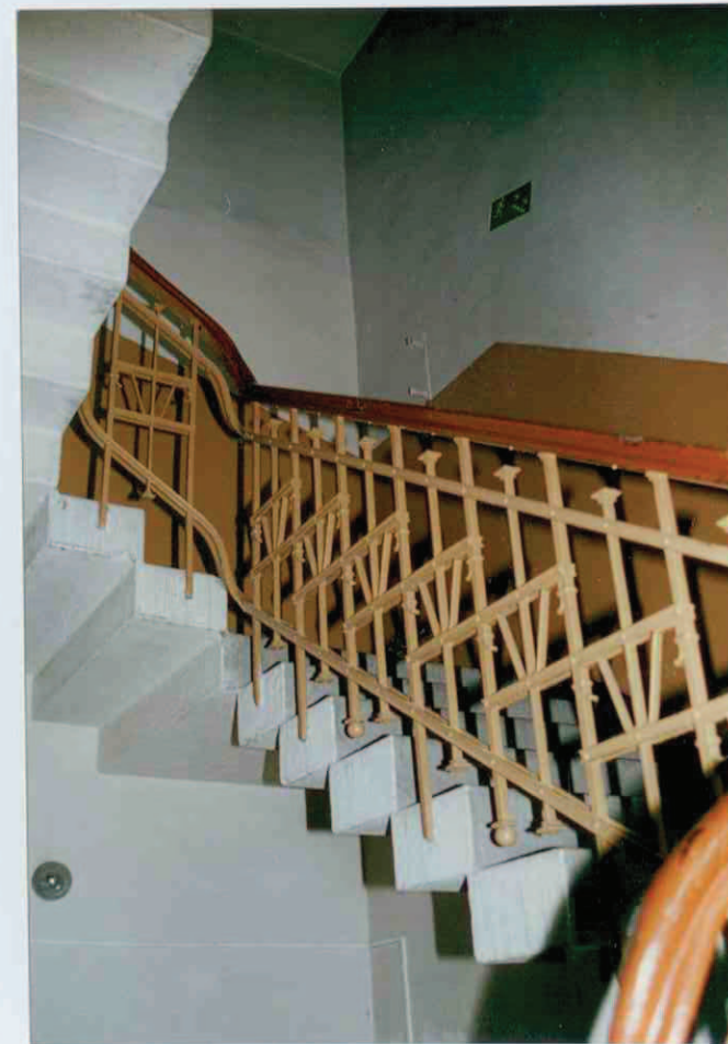
27. Fragment bocznej klatki schodowej.
