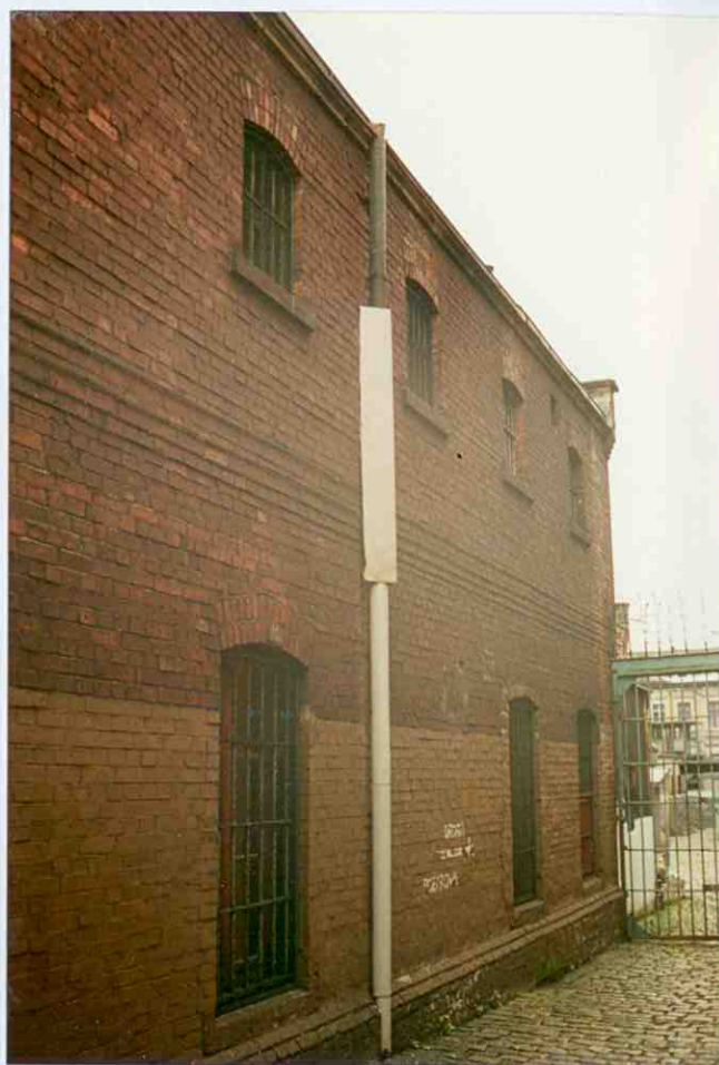
17. Kantyna. Budynek główny-administracyjny. Widok od południa.
