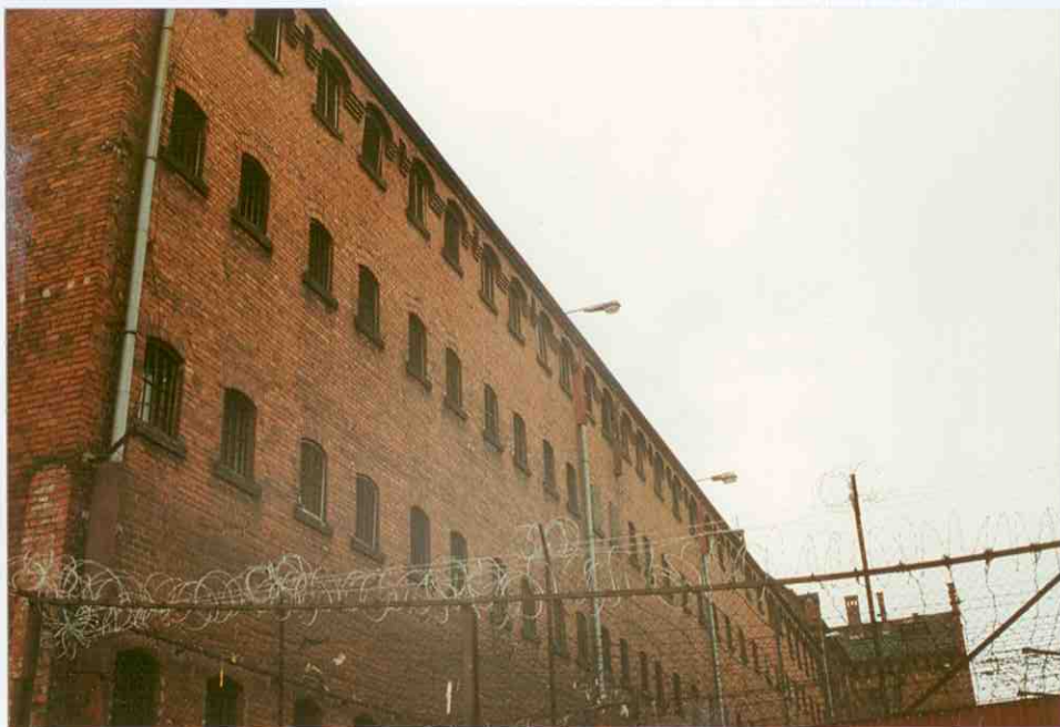
9. Areszt Śledczy. Widok ogólny na elewację południową.
