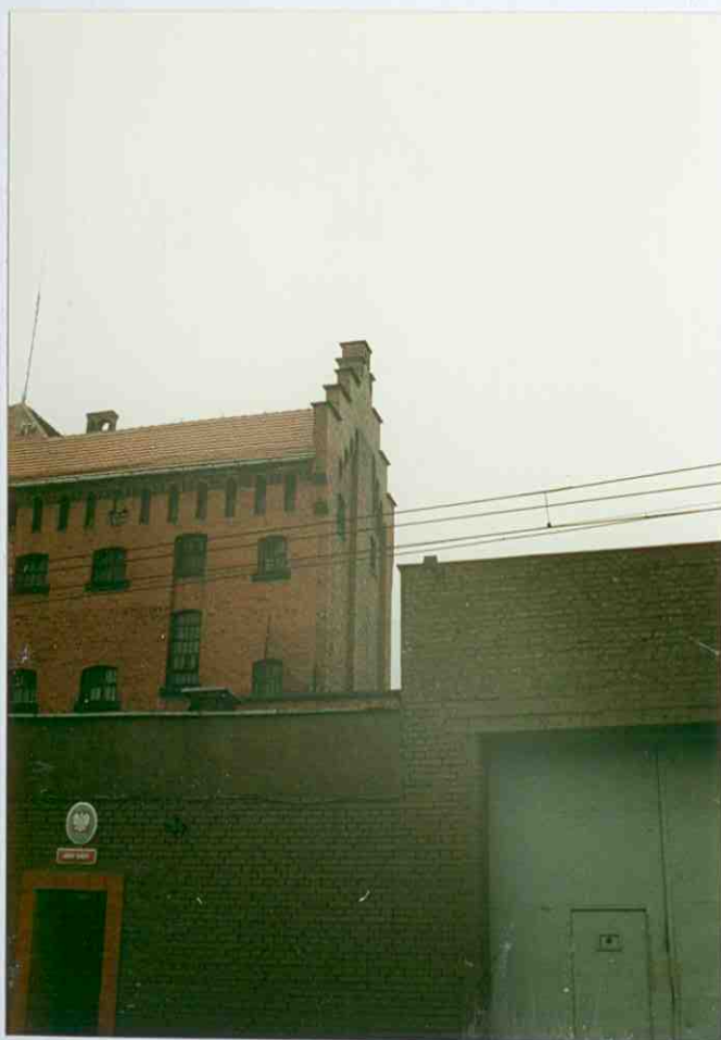
16. Budynek główny-administracyjny. Frag. elewacji szczytowej-południowej.
