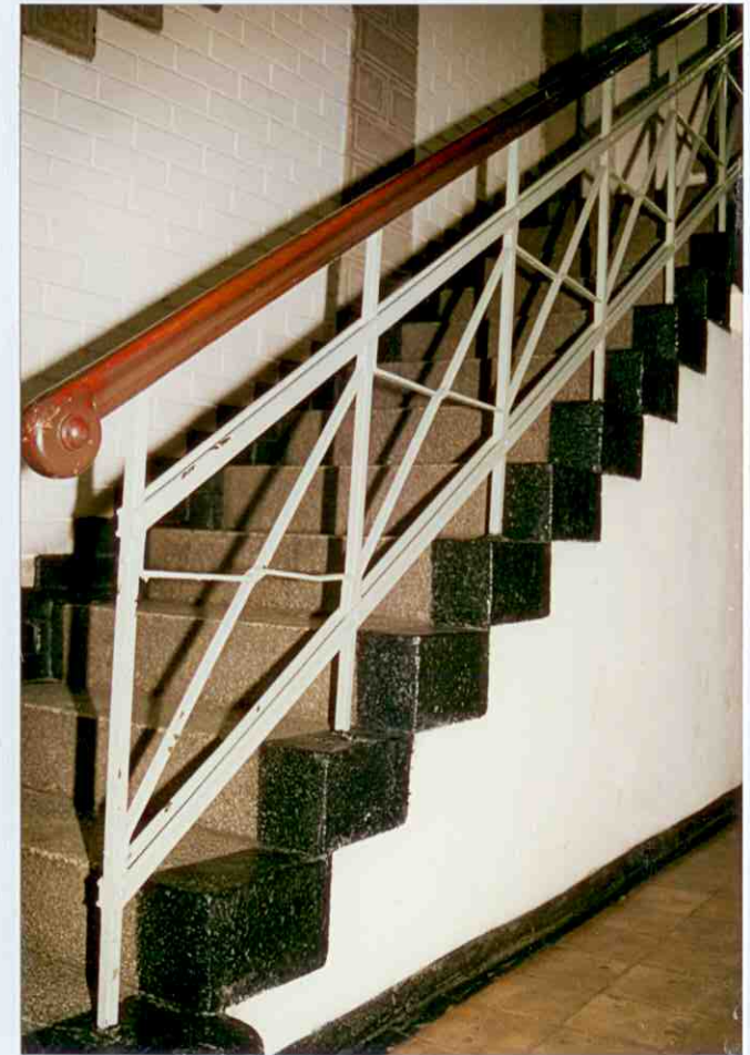
29. Budynek główny-administracyjny. Balustrada. Klatka główna.
