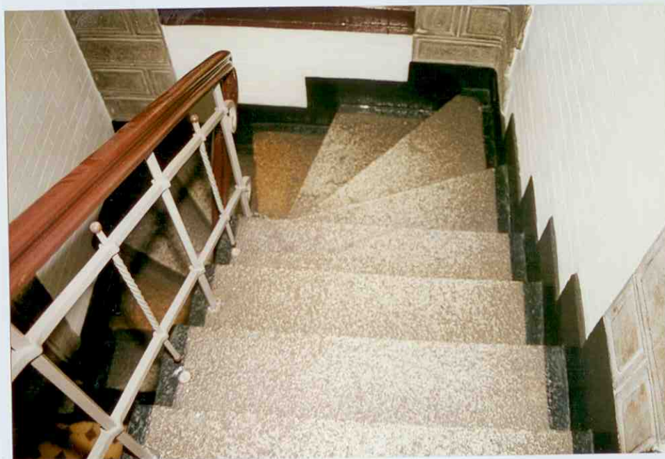
31. Budynek główny-administracyjny. Boczna klatka schodowa.
