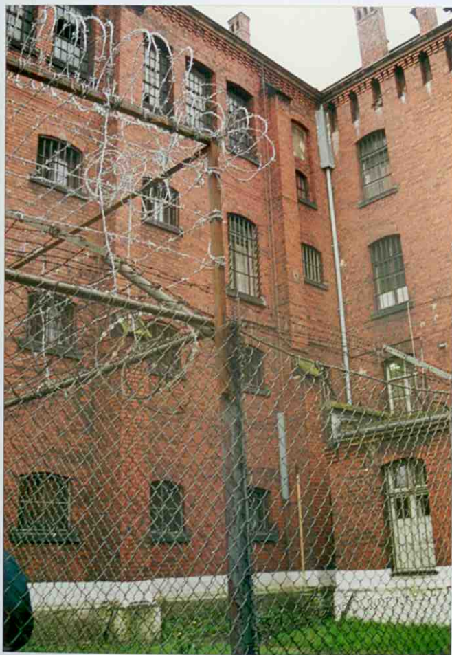
11. Areszt Śledczy. Frag. elewacji północno-wschodniej.
