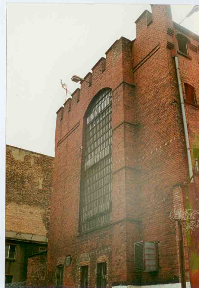
13. Budynek mieszczący oddziały. Elewacja wschodnia.
