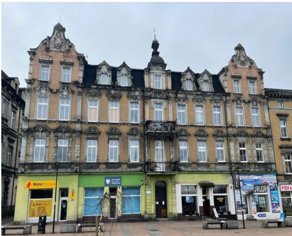
Kamienica w stylu eklektycznym ul. Grunwaldzka 20
