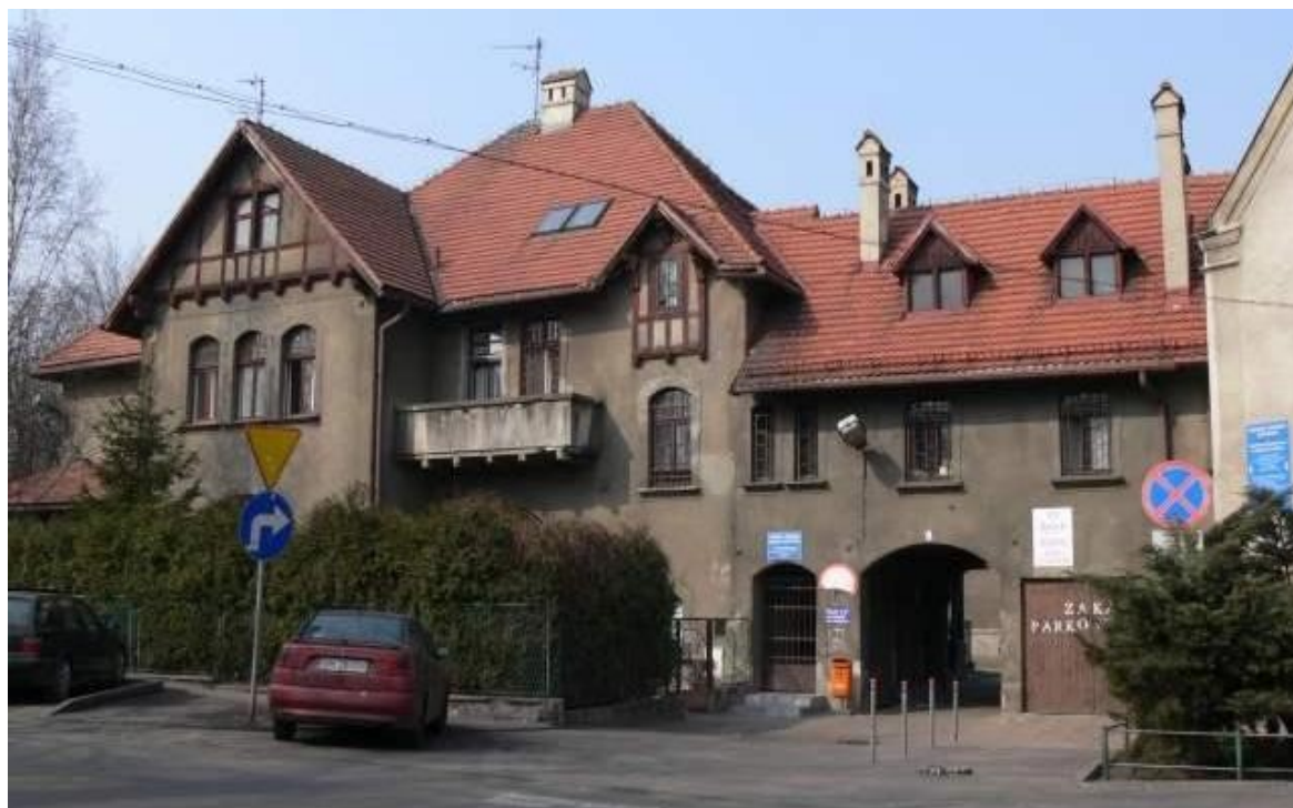
Budynek dawnego Szpitala Brackiego ul. Świerczyny 1
