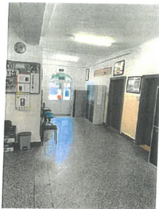
Fot.12 – Strop nad częścią przyziemia
