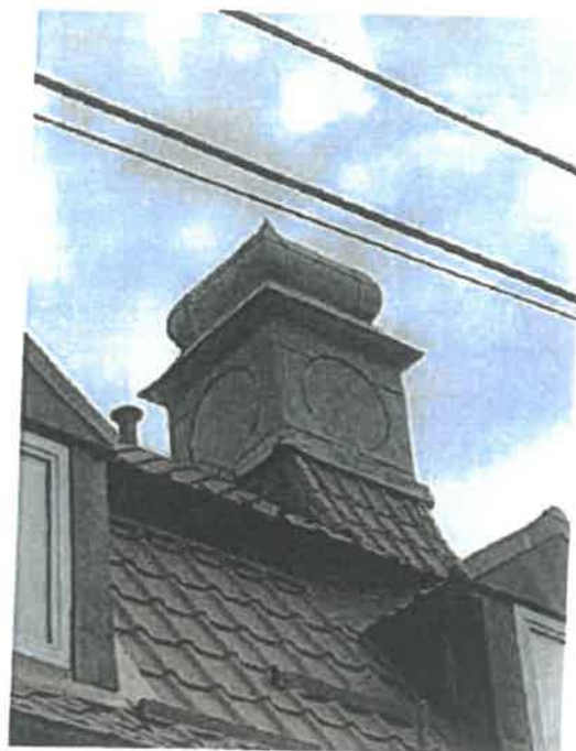
Fot.17 – wieżyczka zwieńczona hełmem i iglicą – widoczne miejsce tarczy zegara.
