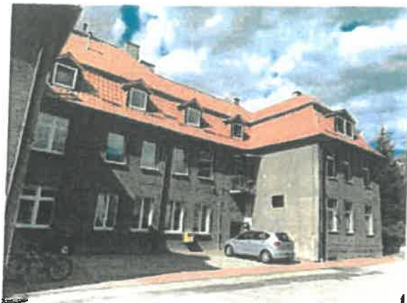
Elewacja tylna budynku.
