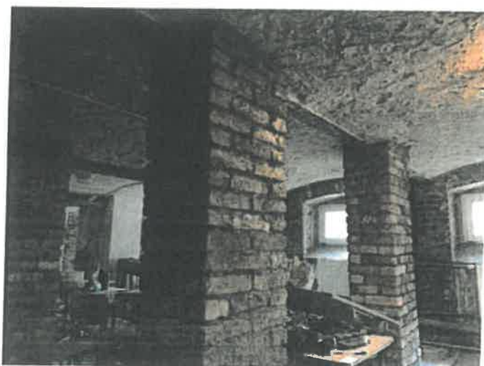
Fot.13 – Słupy podporowe belek stropu nad piwnicą
