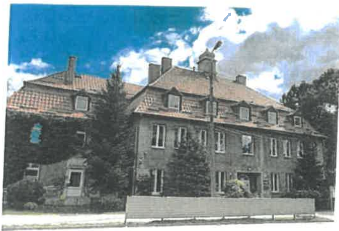
Fot.16 – dach mansardowy z lukarnami – pokrycie blachodachówka
