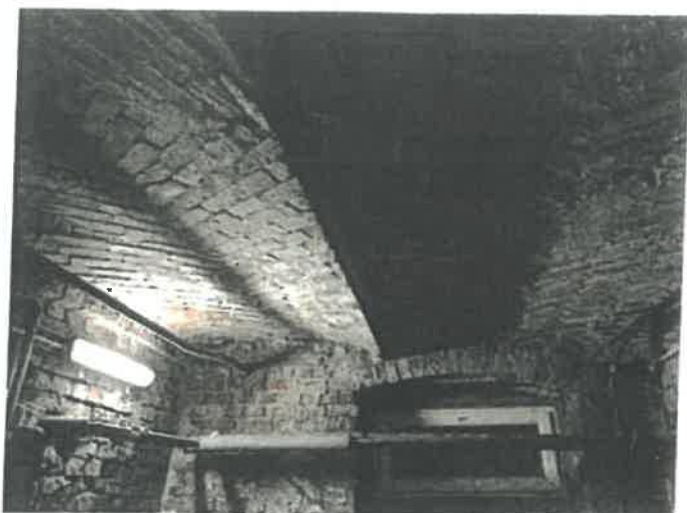
Fot. 11- Sklepienie ceglane nad piwnicą
