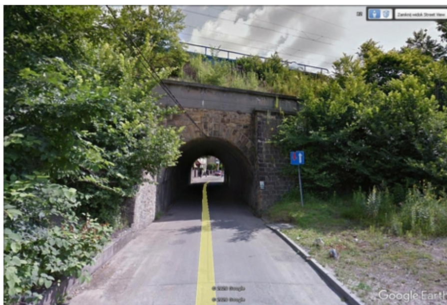
Przejazd pod linią kolejową - ul. Portowa (na wschód)
